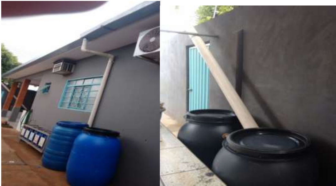
Figura 6. Calha e reservatório prontos
